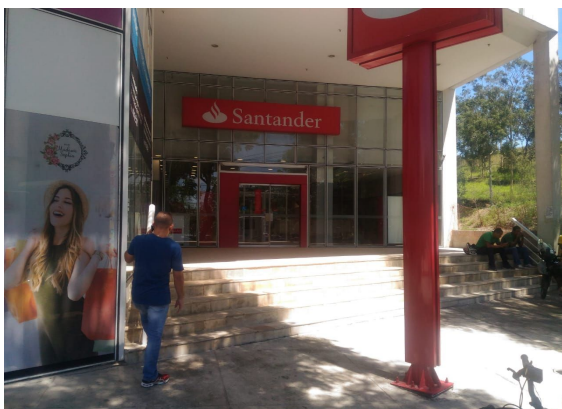
Comercial Parque das Águas - banco -22.825053, -43.010612
