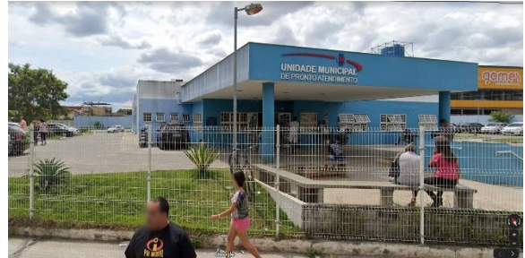
Imagem 14 - Unidade Municipal de Pronto Atendimento - Estr. do Pacheco, 1051 - Área Hospitalar 708491,70 | 7474471,50
