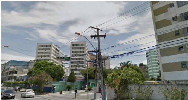
FOTO 03 – Rio Empreendimentos Residenciais Latitude - 22.826608°Longitude --43.015437°
