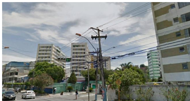
FOTO 03 – Rio Empreendimentos Residenciais Latitude - 22.826608°Longitude ---43.015437°
