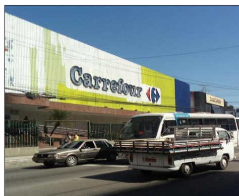
FOTO 04 – Carrefour Latitude -22.824392° Longitude - 43.009532
