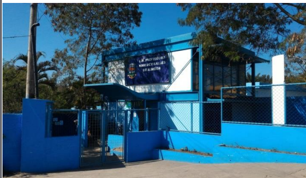
Escola Marluce Salles Almeida. Fonte: Master Ambiental Latitude: -22.810960° Longitude: -43.008589°
