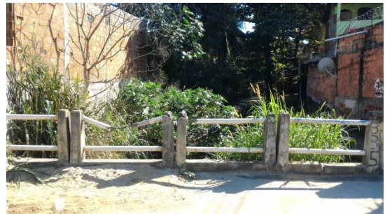
Rio canalizado dentro da All Lat – 22.812554 Lon – 43.012102
