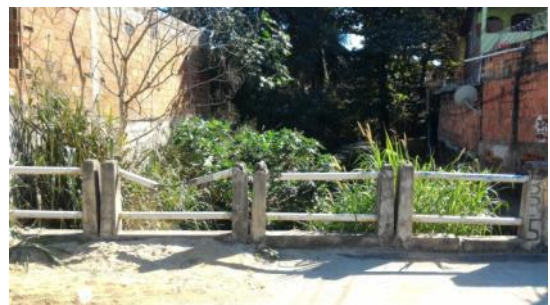
Rio canalizado dentro da All Lat – 22.812554 Lon – 43.012102
