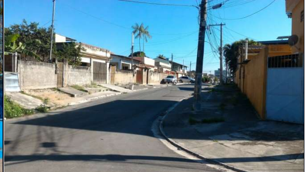
Residências unifamiliares Rua Lavras. Fonte: Master Ambiental. Latitude: -22.812656° Longitude: -43.009617°
