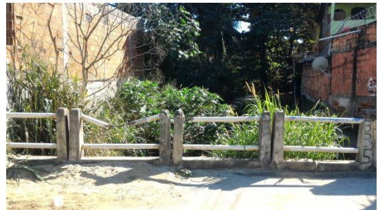
Rio canalizado dentro da All Lat – 22.812554 Lon – 43.012102
