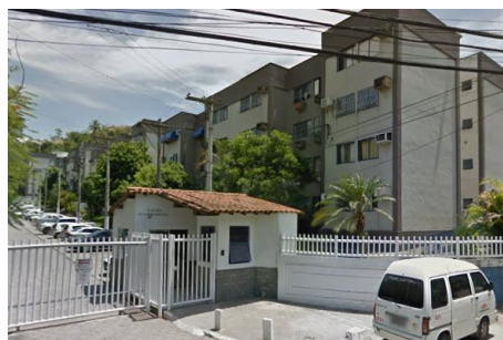
FOTO 02: Condomínio Colinas do Engenho (- 22.85297°; -43.020304°)
