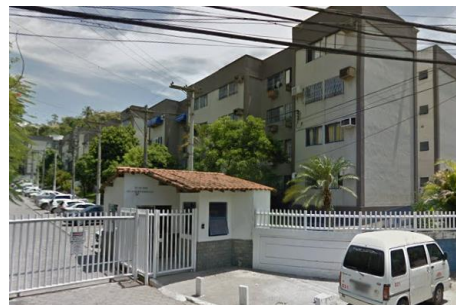
FOTO 02: Condomínio Colinas do Engenho (- 22.85297°; -43.020304°)
