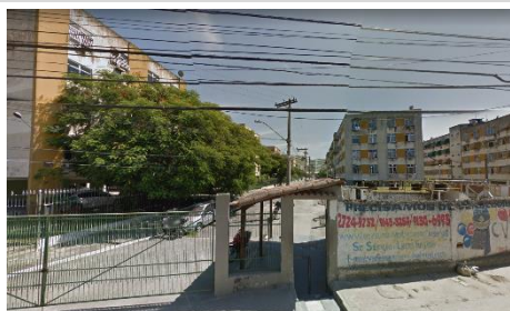
FOTO 09 P2E - Rua Marcílio Noronha - Conjunto Habitacional 703869,08 / 7474195,82
