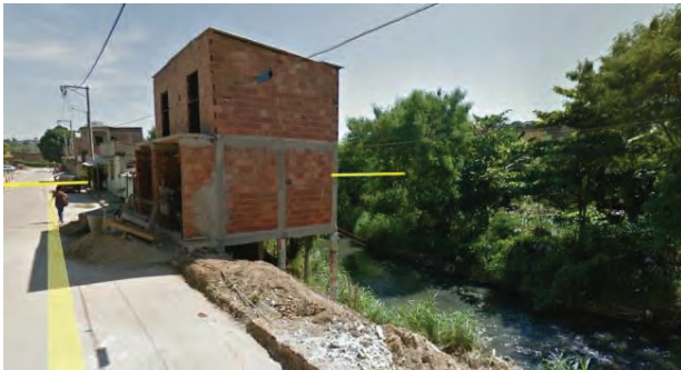
FMP do Rio Alcântara, ocupação irregular e poluição das águas Lat. -22.831514° / Lon. -43.007536°
