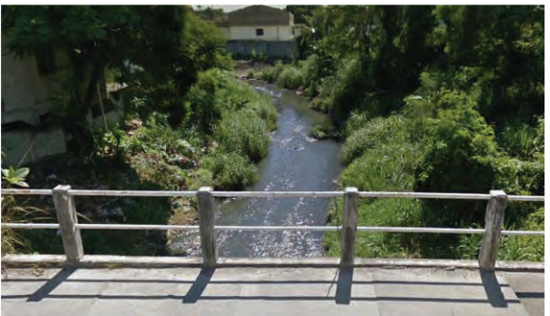
Ponte sobre o Rio Alcântara Lat. -22.833480° / Lon. -43.007044°
