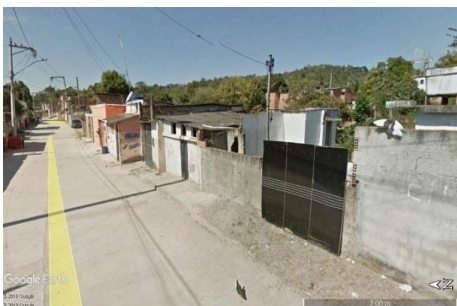
Edificações na AII (Rua Manuel Bandeira) -22.861567° -43.017283°
