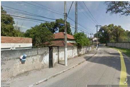
Edificações na AID (Rua Dalva Raposo) -22.864033° -43.019633°
