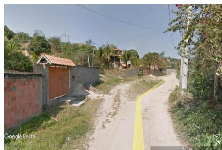
Edificações na AII (Rua Altino Martins de Vitória) -22.863517° -43.017733°
