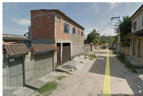
Edificações na AII (Rua Alfeu Rabêlo) -22.860883° -43.019383°
