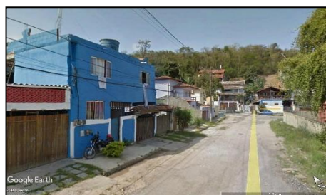
Edificações na AID (Rua José Pinheiro Lucas) -22.869635° -43.022690°
