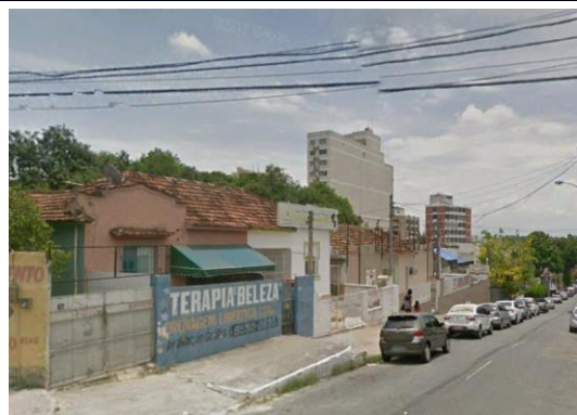
FOTO 04 – Imagem do cruzamento entre as ruas Aluizio de Neiva e João de Souza.
