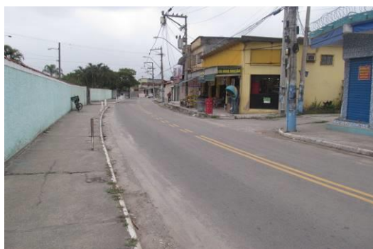
Figura 04 - Comércio próximo ao empreendimento Latitude -22.828620° Longitude -42.980120°
