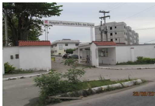
Figura 12 - Hospital Franciscano Nossa Sª das Graças - Latitude -22.823016° Longitude -42.977968°
