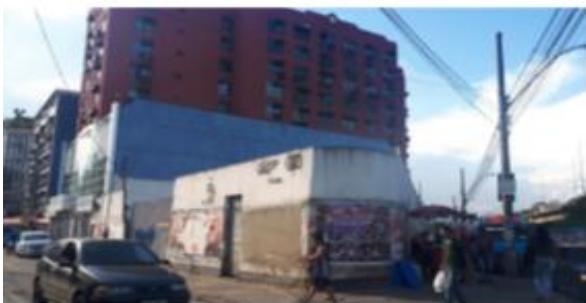
Área do Empreendimento
