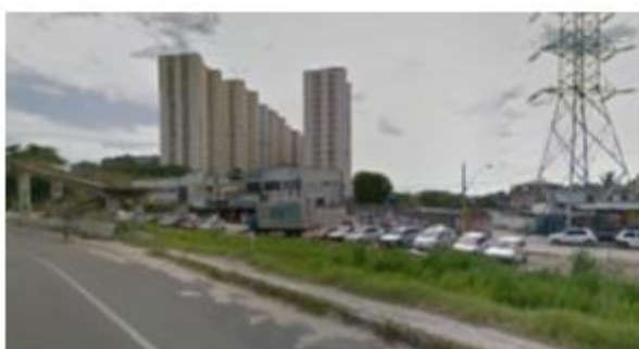
As edificações mais altas do Bairro Alcântara 22°48'55.97"S / 43°00'16.61"O
