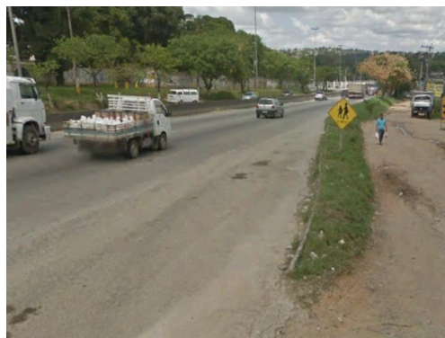
FOTO 08 – Imagem da Rodovia RJ-104 (Sentido São Gonçalo).
