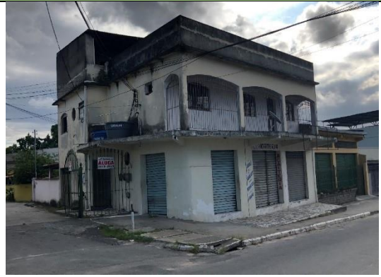
Figura 4: Residências Unifamiliares. Fonte: Master Ambiental, 2021. Latitude: -22.827150°Longitude: -42.981087°
