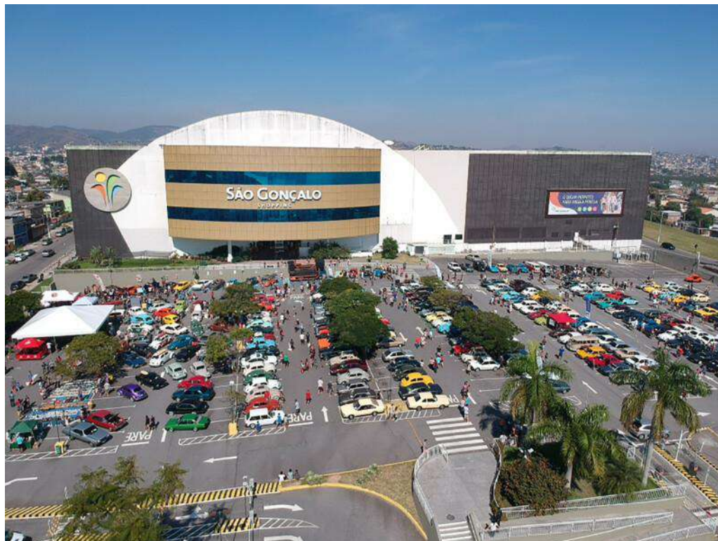
Figura 24 – São Gonçalo Shopping
