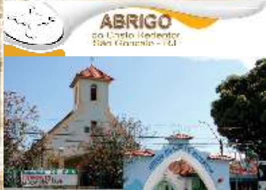
Fachada da entrada do Abrigo. Ao fundo Igreja de São José
