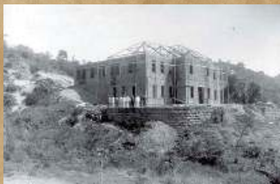
Construção do Hospital de São Gonçalo, data provável, 1933
